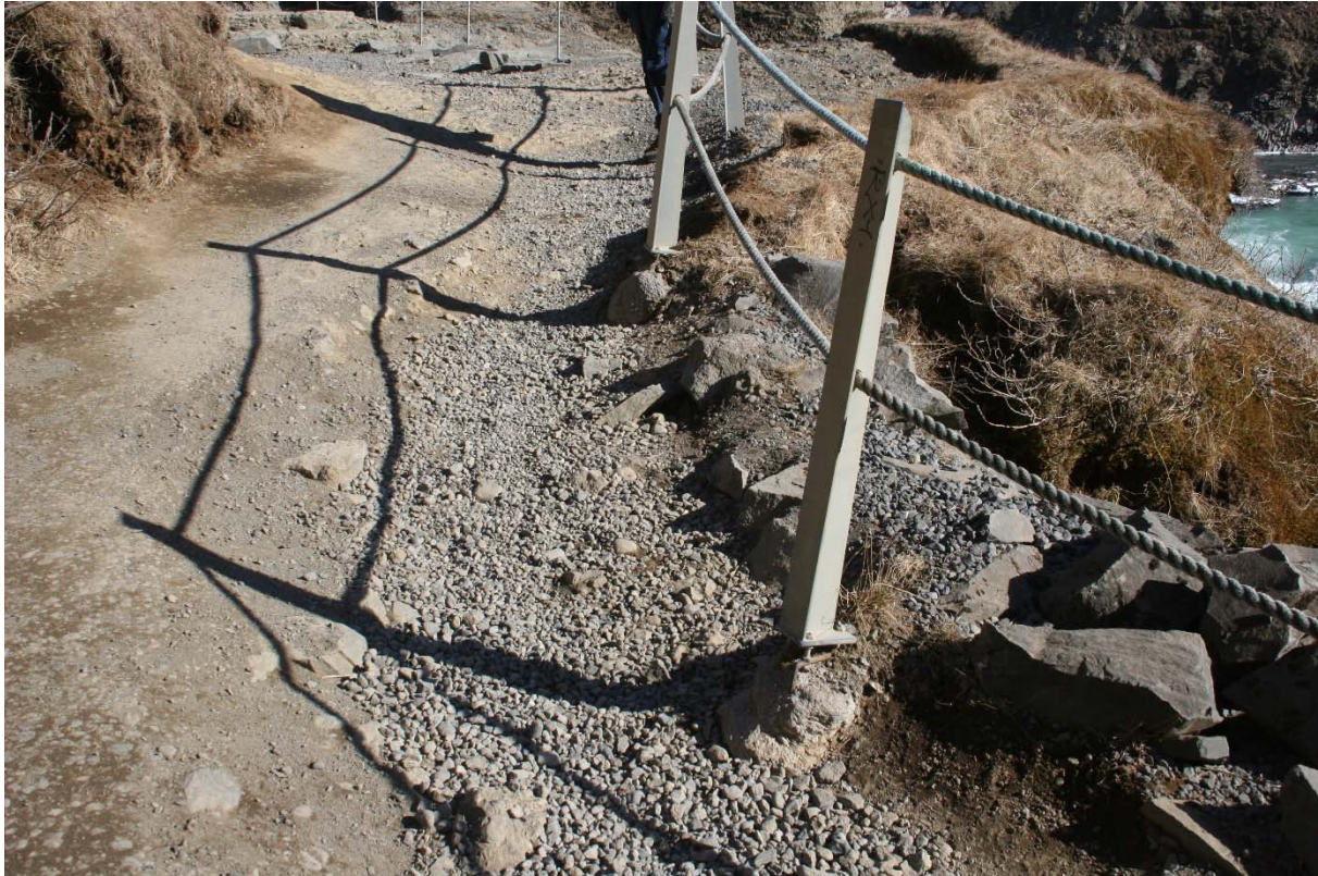
Mynd 3: Sýnir hvernig stígur getur orðið við leysingar og minni flóð. Ljósmynd: MAREY arkitektar, apríl 2013
