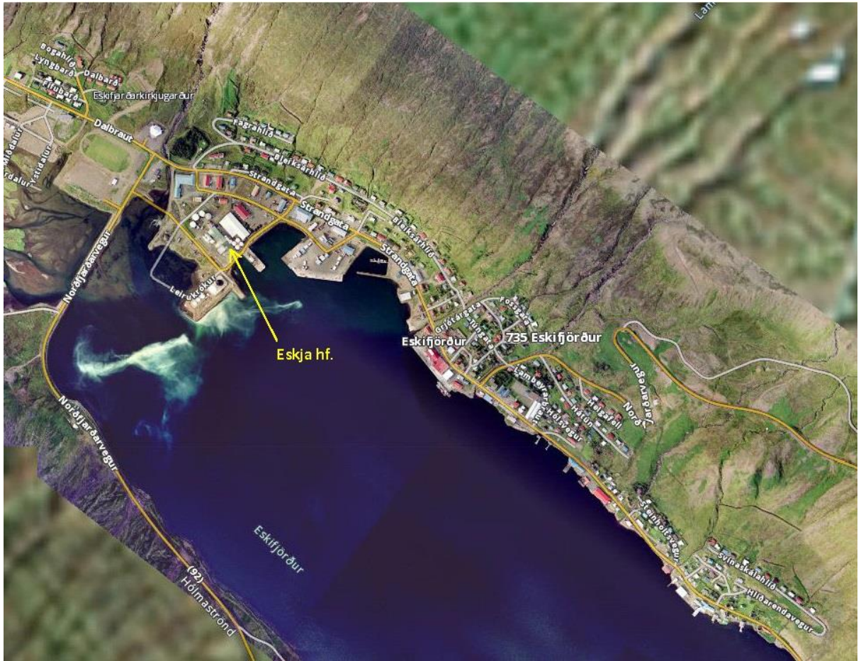
Mynd 2 Loftmynd af athafnasvæði fiskimjölsverksmiðju Eskju hf.
