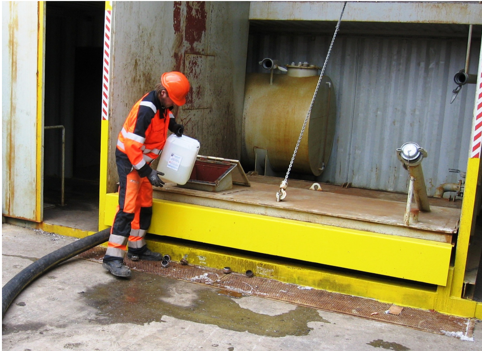
Mynd 10.2. Lyktareyðandi og sóttreinsandi efni blandað í skolvatn í móttökupró við seyruholu.
